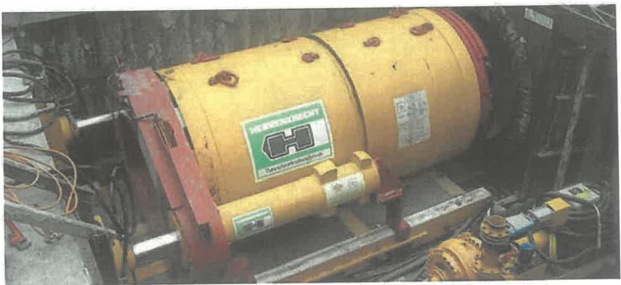
Fig. 4 Ansamblu format din cricuri hidraulice și cap freză
