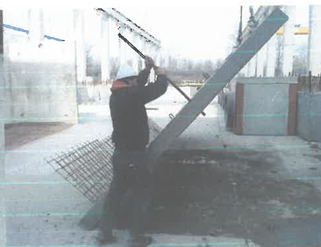
Fig.2 Montarea armăturilor și a elementelor înglobate
