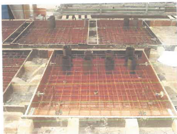
Fig.2 Montarea armăturilor și a elementelor înglobate
