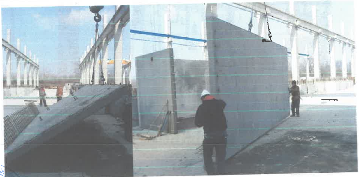
Fig.3 Pregătirea elementelor pentru îmbinare și fixarea acestora - continuare
