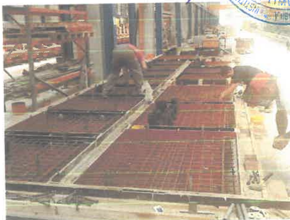
Fig.2 Montarea armăturilor și a elementelor înglobate
