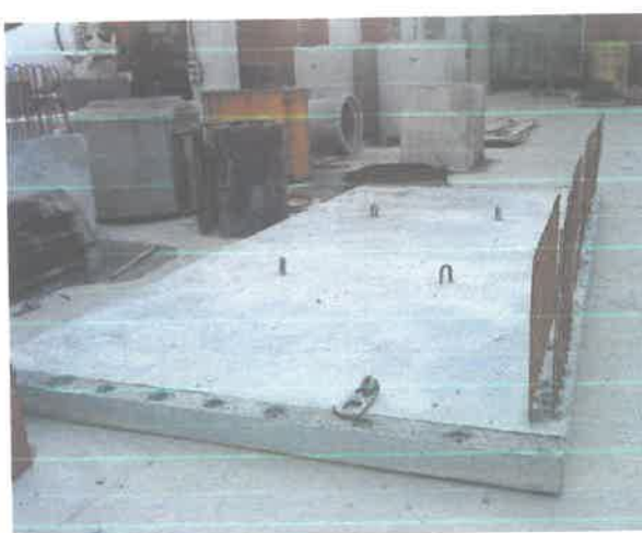
Fig.3 Pregătirea elementelor pentru îmbinare și fixarea acestora
